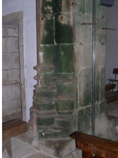
Fig. 4: Biofilme de microrganismos fotossintéticos sobre granito da Igreja de Vilar de Frades (Barcelos).
